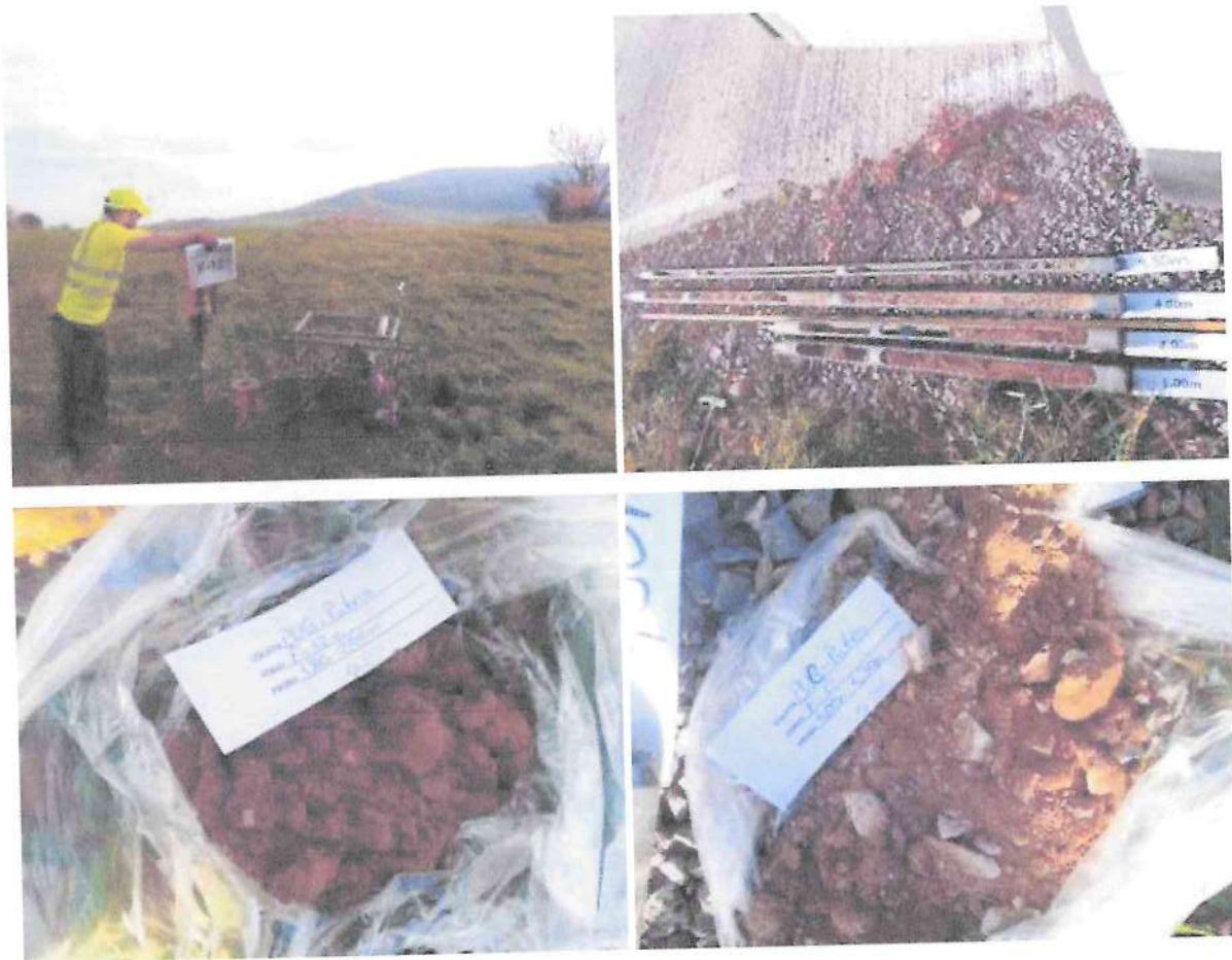
Fig. 25. Realizare investigații geotehnice și prelevare probe de pământ
